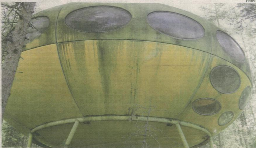
Luonnon armolla. Tältä avaruustalon ulkopinta näytti ennen kunnostusta.
